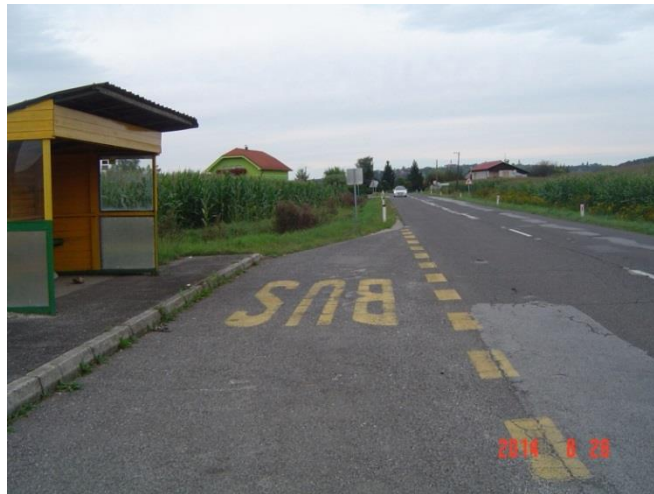
Križišče, prometna cesta, nevarno prečkanje ceste, ni prehoda za pešce, ni pločnikov
