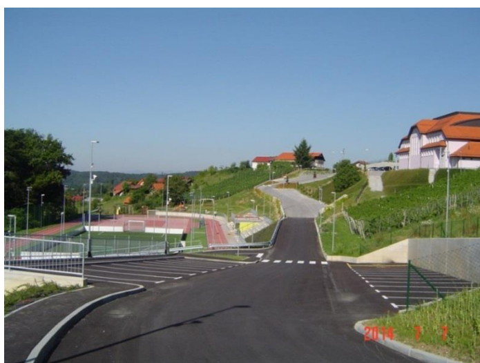
Pogled na urejena parkirišča pod šolo.
