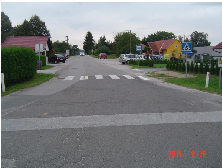
Prehod za pešce na državni cesti R3 745 v Janežovcih
